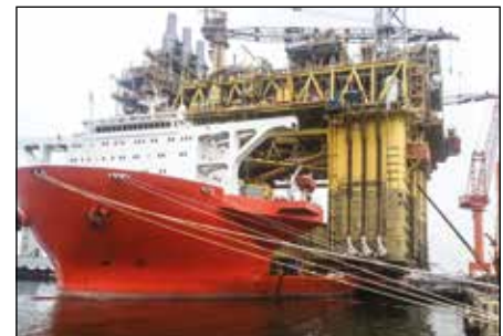
Super-levage et pose synchronisés
