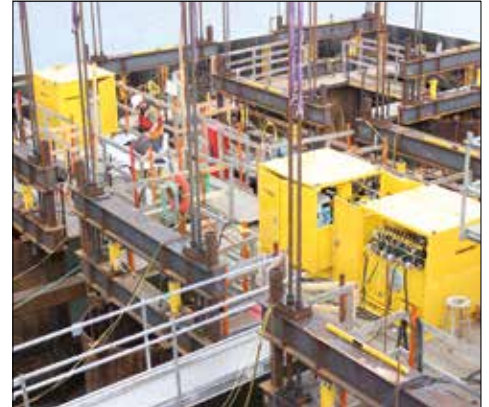
▲ Pompe hydraulique personnalisée pour un système de mise en place de tablier de pont.
