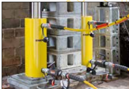
Levage et pose de pont
