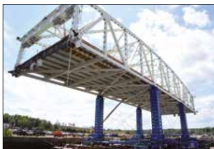
Levage progressif de pont
